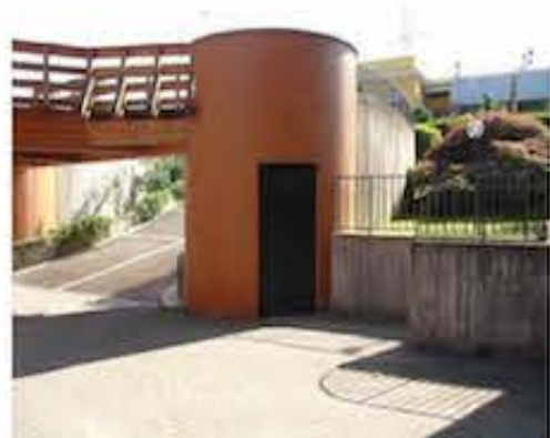
Locale dei rifiuti
